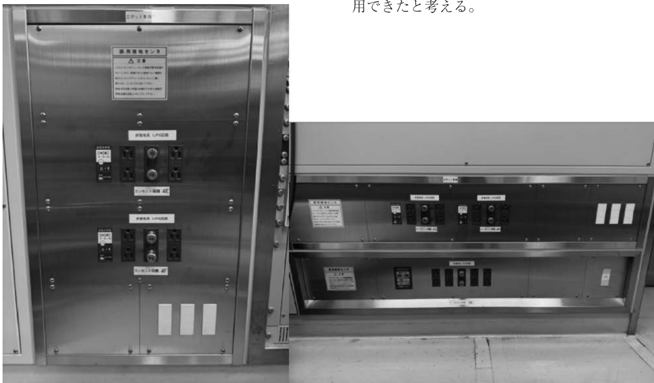
図4 増設された無停電電源と LAN ポート
